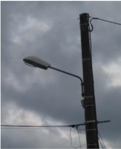
**Figure 5 : Luminaire « Saphir » équipé d'une vasque bombée et installé sur une crosse inclinée à 8 mètres de hauteur : orientation de la lumière non optimale avec flux de lumière perdue.**
