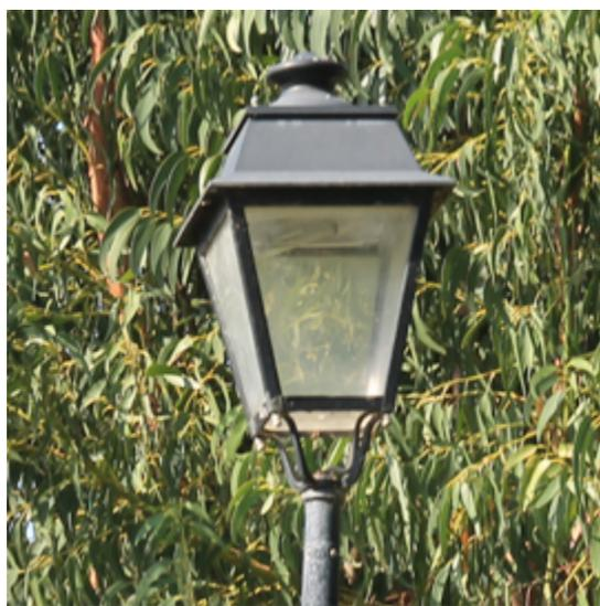
**Figure 7 : Luminaires de style avec réflecteur optique, permettant un meilleur contrôle du flux lumineux (les vitres latérales participent quand-même à une diffusion de lumière directement vers le haut, amplifiée par le salissement). Mais l'ANPCEN a constaté que plusieurs d'entre eux présentaient une ampoule inclinée dépassant du réflecteur générant un important flux perdu et un éblouissement causé par une installation non optimale.**
